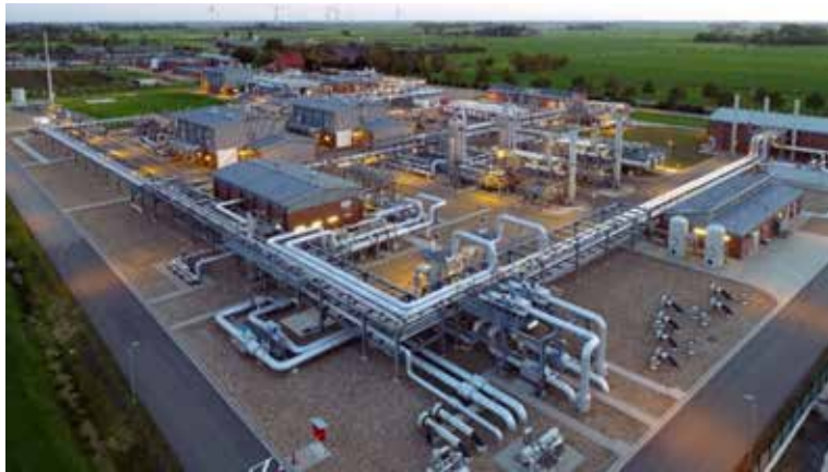
Instalaciones de un almacenamiento de gas de Gazprom ubicadas en Jemgum (Alemania) 22
